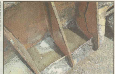
Água acumulada dentro de pedaço de escavadeira
