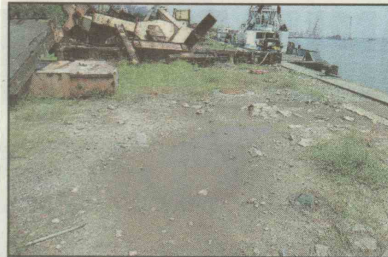
No meio do terreno, a água empoçada é convite
